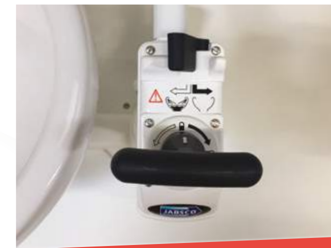
3 WC lever into position « flushing »
